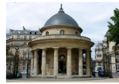
The Barrière de Chartres Rotunda, by Claude-Nicolas Ledoux, for the Wall of the Ferme générale, 1786-1792, parc Monceau, Paris.
