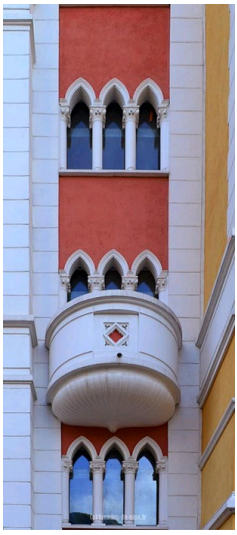
Front detail, château des Ollières.
